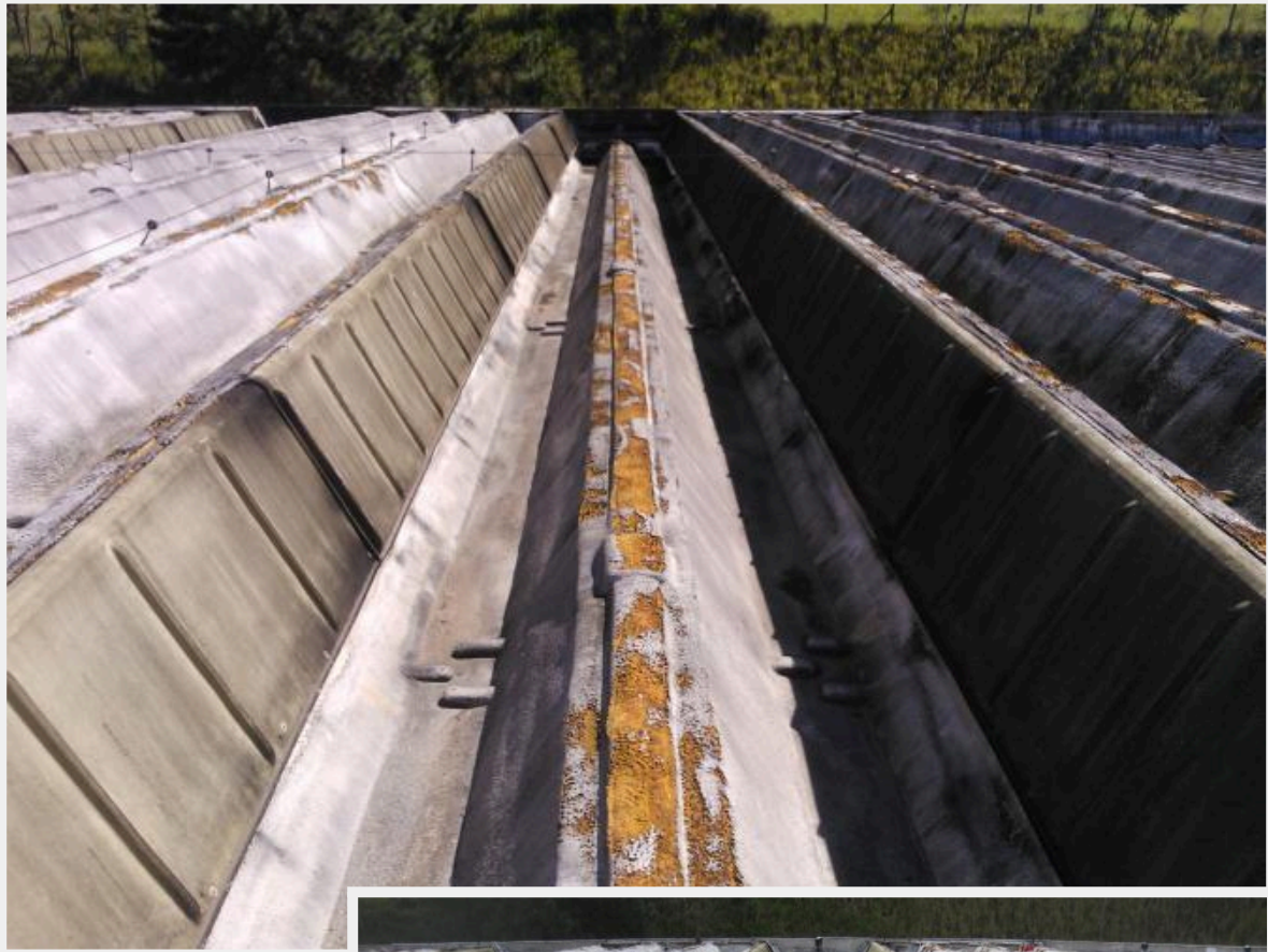
Telhado - antes (acima)
