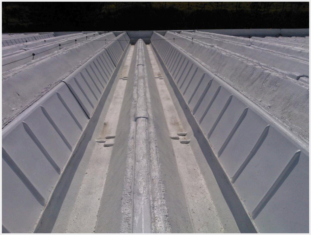
Telhado com revestimento ACRILTHERM
