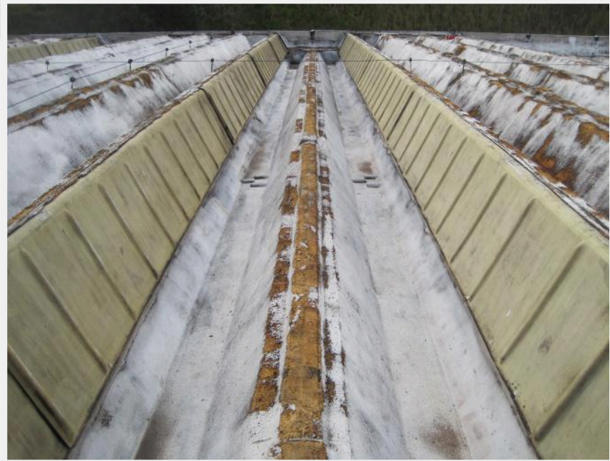
Telhado - pós lavagem (ao lado)
